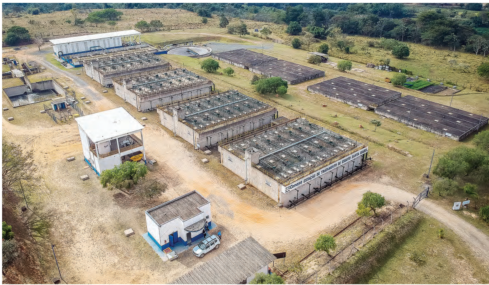
VISTORIA TÉCNICA FEITA POR TÉCNICOS DO SAAE, DA SANESALTO E DA ARES-PCJ, IDENTIFICOU DIVERSOS PROBLEMAS NA ETE SANTA ISABEL E EM TODO O SISTEMA DE COLETA E TRATAMENTO DE ESGOTO
