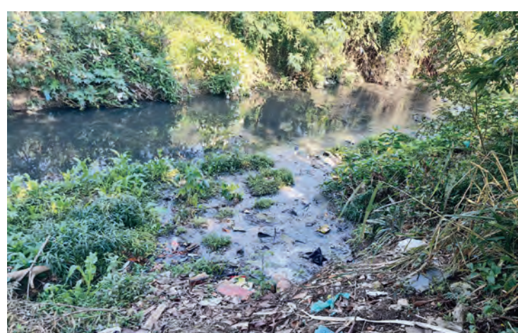
ESGOTO VAZANDO DAS ESTAÇÕES ELEVATÓRIAS FOI ALGO COMUM IDENTIFICADO DURANTE A VISTORIA TÉCNICA
